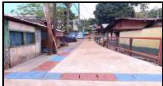
Foto Sesudah Penanganan
