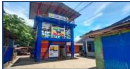
Foto Sesudah Penanganan
