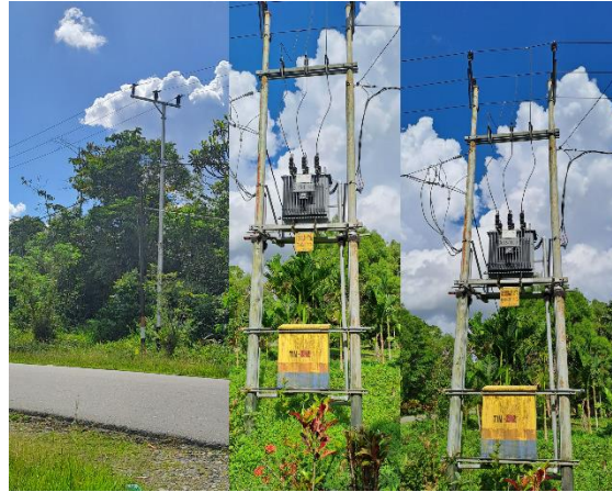
Gambar 12 Tinag dan mini-Sub Station listrik Kampung Utikini Baru
