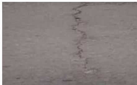
Gambar 2. 23 Pinggiran Jalan Turun Vertikal
