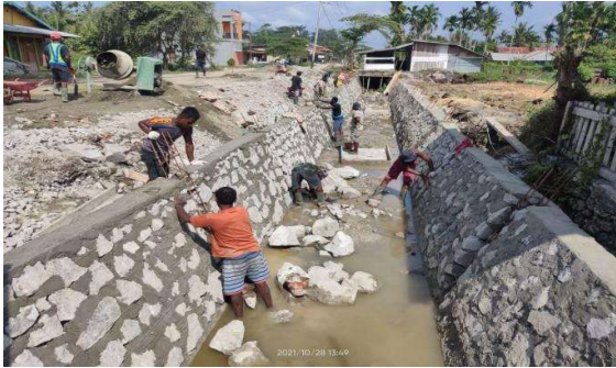
Gambar 1.2 Pengerjaan Saluran Drainase
