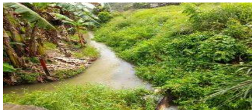
Gambar 1.1 Awal Saluran Drainase
