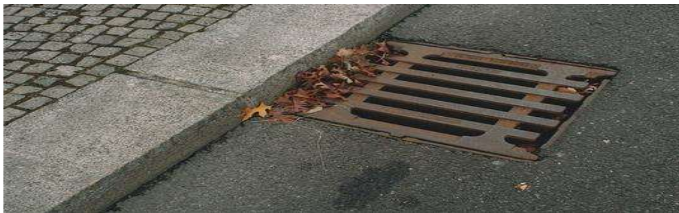
Gambar 2.6 Saluran drainase tertutup
